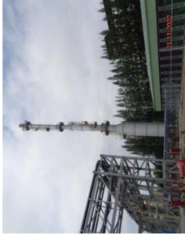
Thermal Oxidizer (TO) ระบบ Three Stage Combustion
